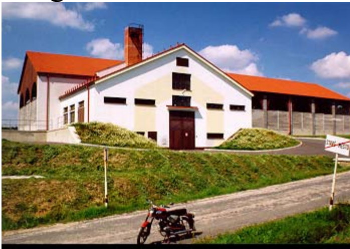
Biomasseheizwerk Staré Město
